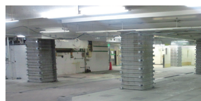
耐震補強工事実施済みの橋脚
