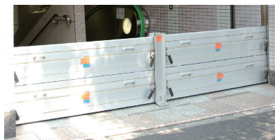
駅出入口の止水板
