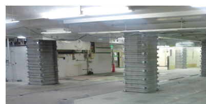
耐震補強工事実施済みの橋脚
