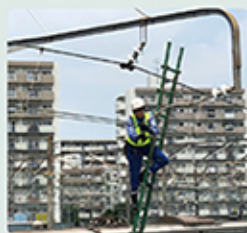
でんしゃせんりんさ ようす 電車線検査の様子
