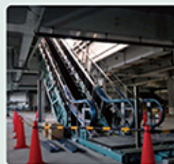
えきかいこうこうご ようす 駅改良工事の様子
