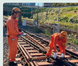
線路補修作業
