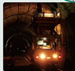
でんけん ようす トンネルの点検の様子
