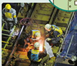
夜間の線路工事
