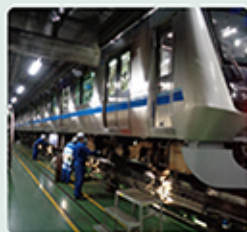
でんしゃ せかしたてんけん ようす 電車の床下点検の様子
